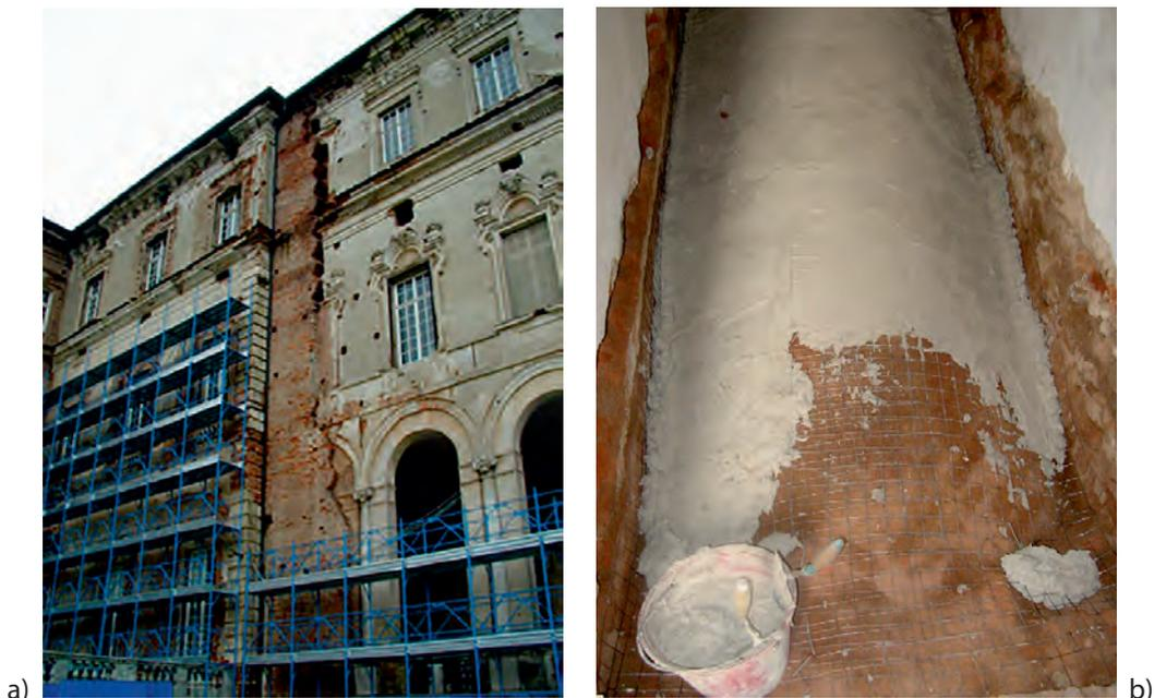
Figura 1: a) Cantiere della Reggia di Venaria; b) Consolidamento estradossale di volta.
